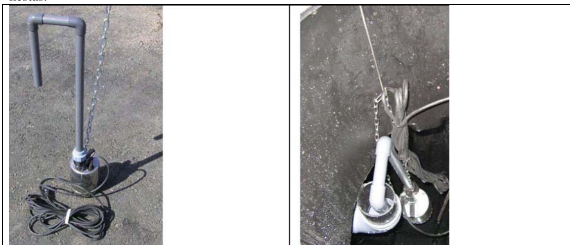
Joonis 15. Tühjenduspumba paigaldamine hooldusšahti.
