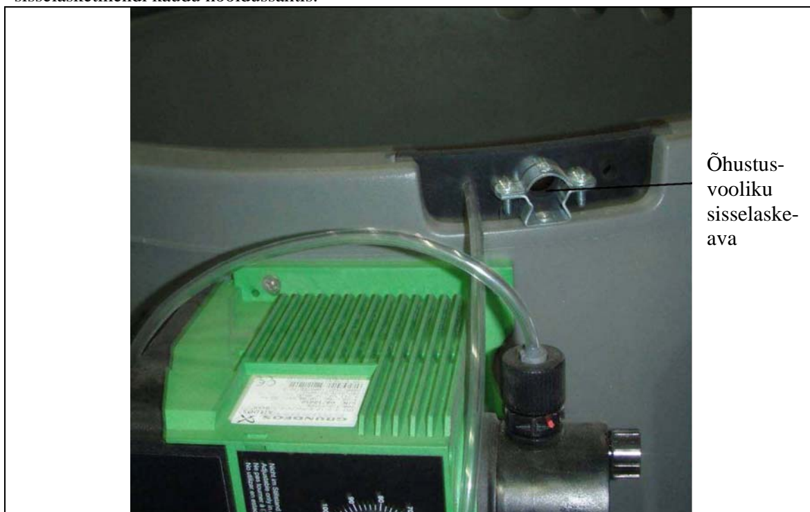
Joonis 14. Kompressori õhustusvooliku sisselaskeava seadme kestast töötluspaagini.
