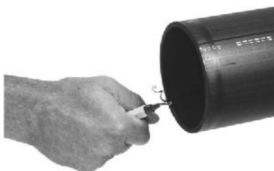
52.att. Noņemiet nelīdzenumus no caurules gala, ja izmantojat zāģi.
