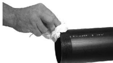
54.att. Notriet caurules galu ar PE tīrīšanas līdzenumu.
