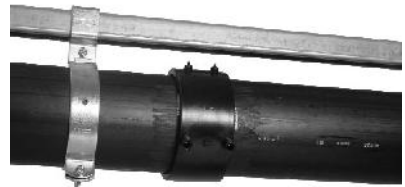
61.att. Demontējiet pagaidu caurules skavu.
