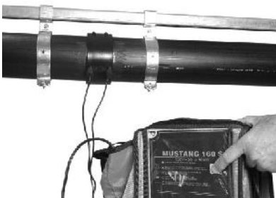
59.att. Rūpīgi nostiprināšana pirms metināšanas.
