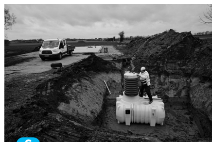
6 Opførselsrør sættes i muffe på tanken.
