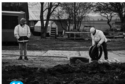
11 Opførselsrør afsluttes med dækselløsning.
