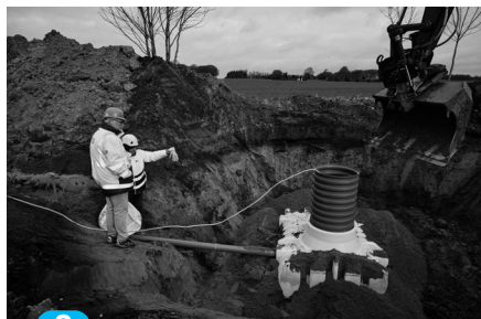
8 Tanken fyldes løbende med vand i takt med omkringfyldning.
