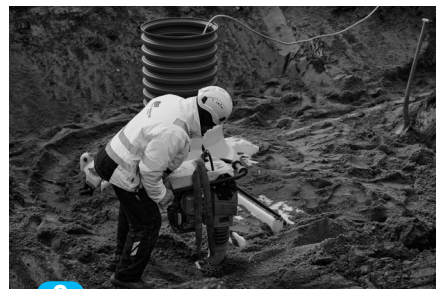
9 Tilfyldning skal ske jævnt rundt omkring tanken.
