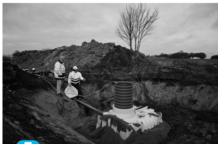
7 Gummiringen monteres på pumpebrøndens opførselsrør, hvilket sikrer en tæt samling mellem pumpebrønd og opførselsrør.
