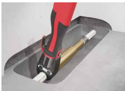
Fig. 24: Installationssteg för reparationskoppling.
