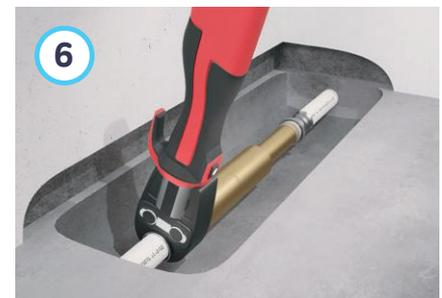
6 Zweite montierte Verbindung verpressen.
