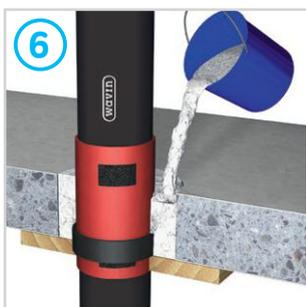
Durchbruch (Wand/Decke) durchgehend mit Beton oder Mörtel verschließen.
