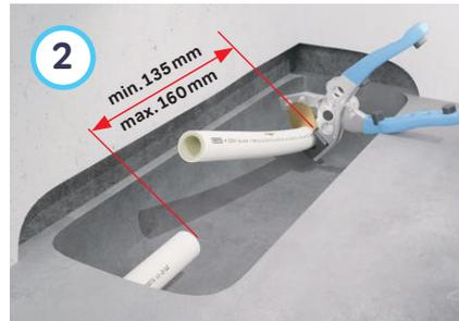
2 Beschädigte oder undichte Rohrbereiche herauschneiden.
