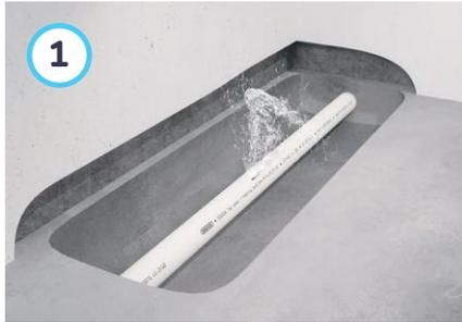
1 Bereich um die Leckagestelle freilegen, falls z. B. mit Putz oder Beton bedeckt.
