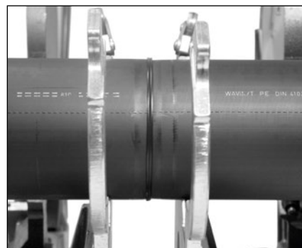
Správně vytvořený svařový spoj natupo
