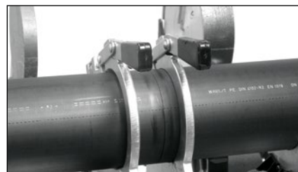
Správně připravené potrubí ke svařování
