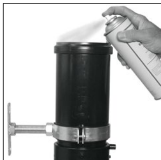
Mazání styčných ploch mezi trubicí a kompenzačním hrdlem
