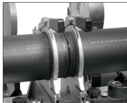
Chladnutí svařeného spoje
