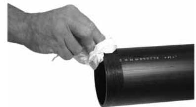
Illustration 52 Nettoyage de l'extrémité d'un tube au moyen d'un agent de nettoyage pour PE
