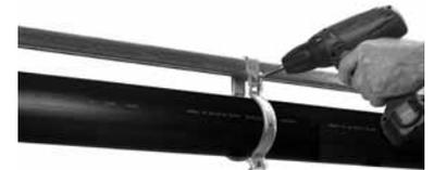
Illustration 80 Serrage de la vis supérieure de fixation
