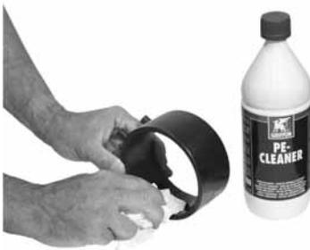
Illustration 54 Nettoyage de la paroi intérieure du manchon au moyen d'un nettoyant pour PE
