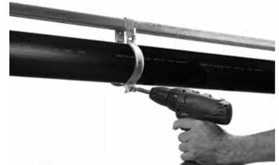
Illustration 79 Emboîtement de la partie avant du collier sur le crochet et serrage de la vis inférieure de fixation.
