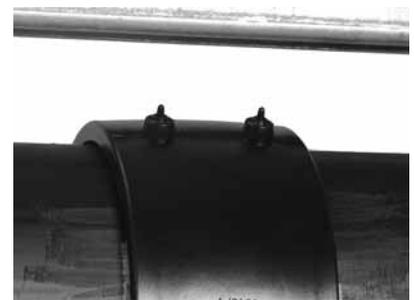
Illustration 57 Contrôle de la profondeur d'emboîtement et des indicateurs de soudage
