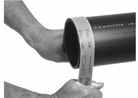
Illustration 50 Ponçage d'une canalisation au moyen d'un ruban abrasif de grain 40 ou inférieur
