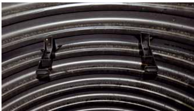
Trepju balsta iepriekšējā montāža stāvcaurulē.
