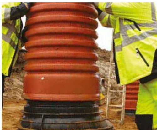
Om förhöjning (utöver konan) kan ett TEGRA 600 stigarrör monteras. Det måste vara ett stigarrör med muff i ena änden. Ett sådant stigarrör finns i längder om 1,5 och 3,5m längder.
