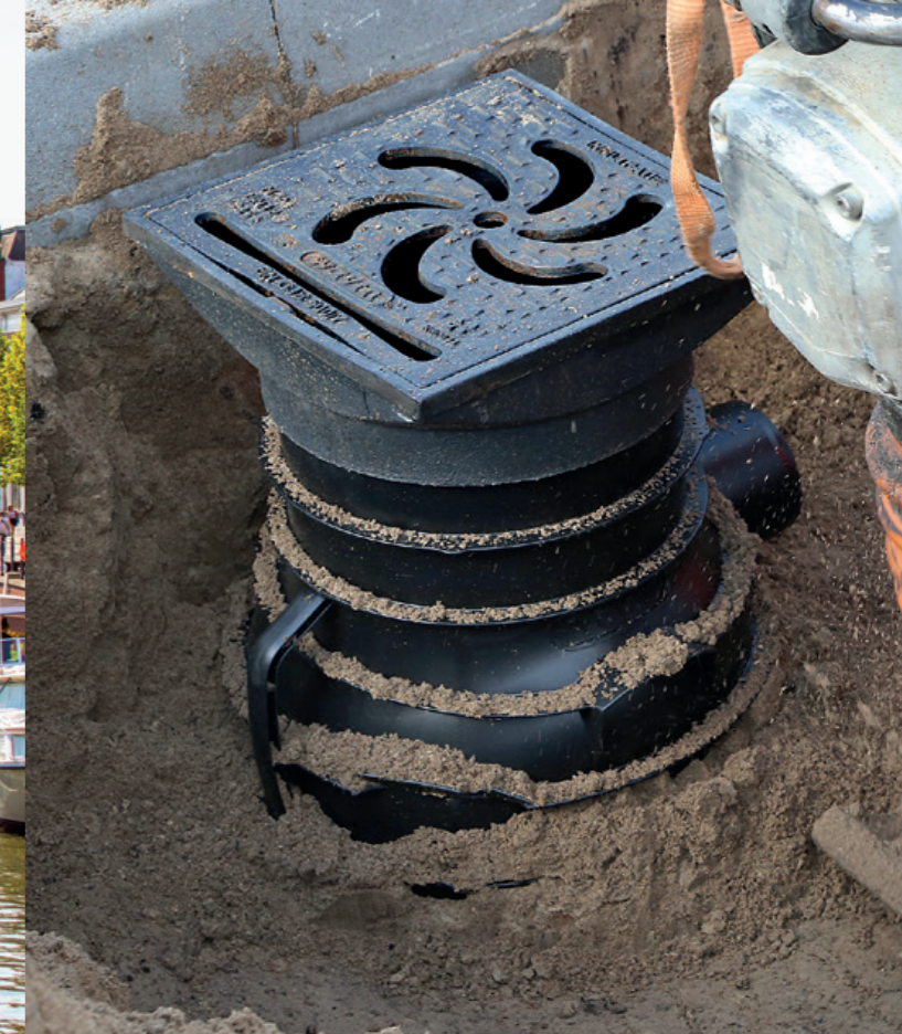
Installation av en Tegra Dagvattenbrunn PLUS.
