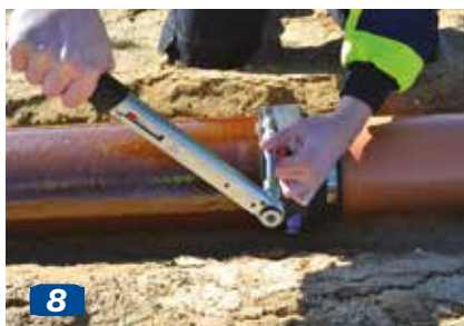
8 Til sidst spændes der efter med momentnøgle.
