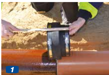
1 Overgangen måles op.
