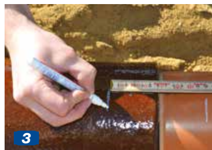
3 Det samme udføres på rør nummer 2. Halvdelen af det opmålte mærkes op.
