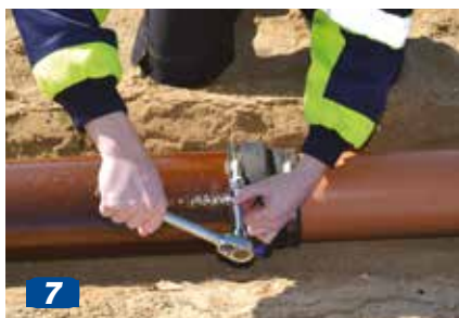
7 Overgangen spændes med skraldenøgle eller med skruetrækker til den sidder fast på rørene.
