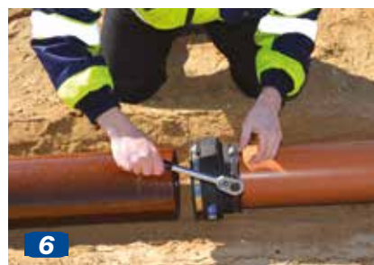
6 Rørene skubbes sammen, således at manchetten passer med de påtegnede indstiksmærker.
