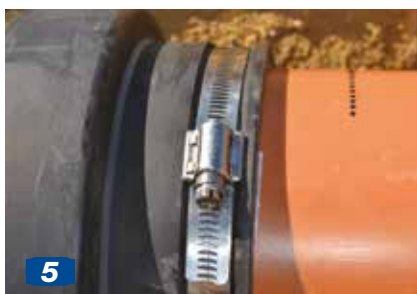
5 Manchetten påsættes det gamle rør. Husk markeringen.
