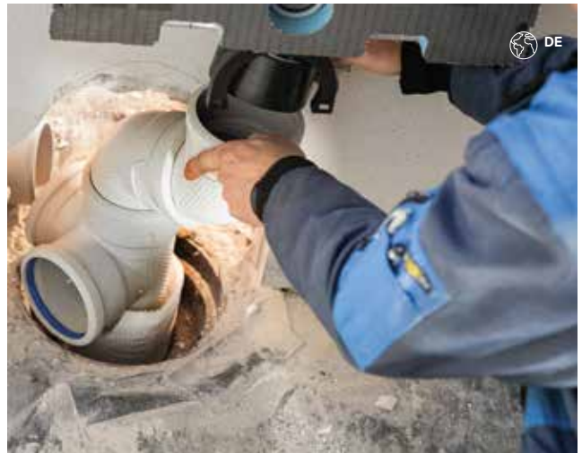
Bild 42: Installation av ett avloppssystem för en golvplatta
