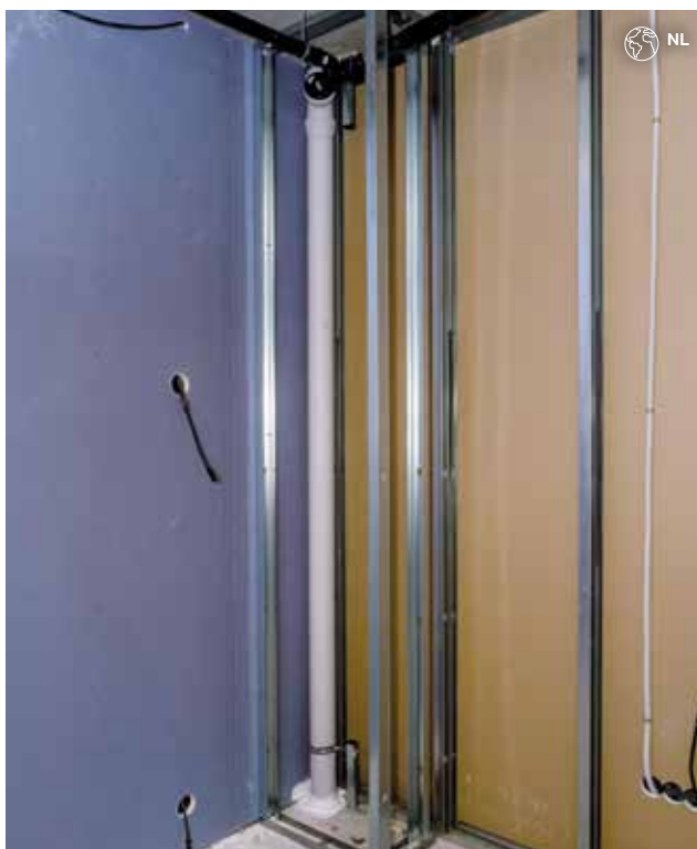
Bild 12: Gipsväggar med fäste via beslag i tak och golv
