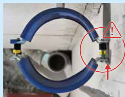
Bild 40: Justera rörfästena korrekt
