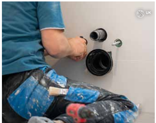
Bild 43: Installationsförberedelse för keramiken
