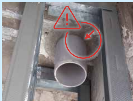
Bild 20: Bortglömd frikoppling för stomljud
