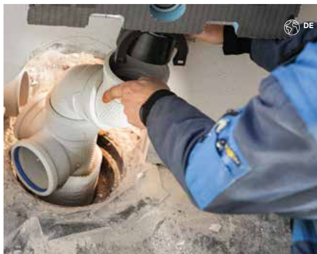
Bild 42: Installation av ett avloppssystem för en golvsplatta
