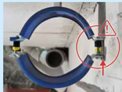
Bild 40: Justera rörfästena korrekt
