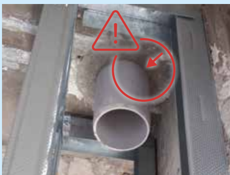
Bild 20: Bortglömd frikoppling för stomljud
