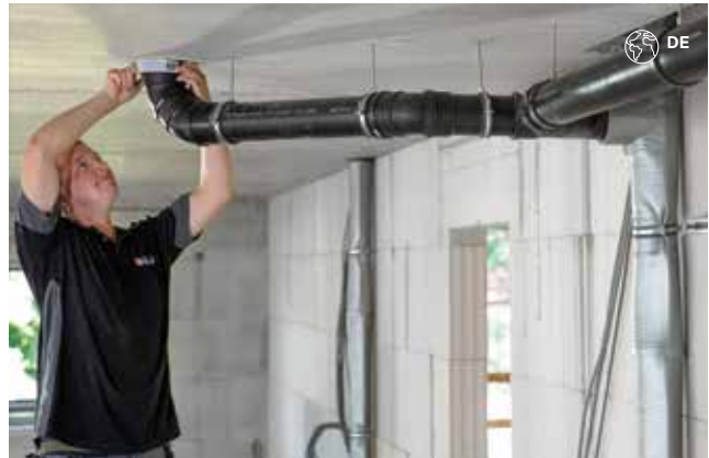
Bild 39: Avloppsrör med ljudisolerings slang
