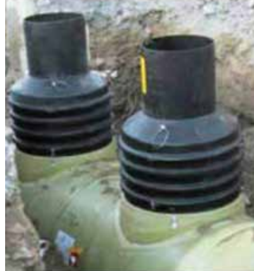
Şekil 6: EuroHUK 600 muayene bacası uygulaması
