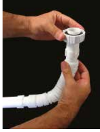
2- Hepvo® Koku Önleyici diyaframın geniş tarafının rakorunu sökünüz ve körük hortumunu birleştiriniz.
