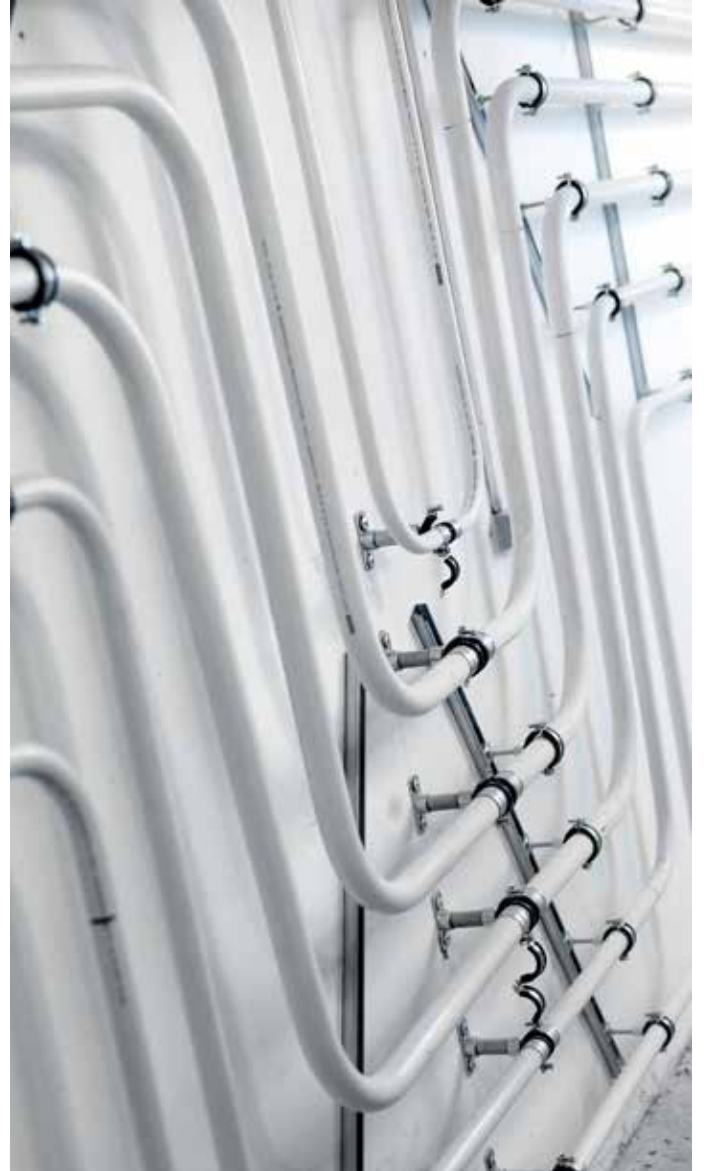
Şekil 1: Ek parça kullanılmadan oluşturulan güvenilir tesisat
