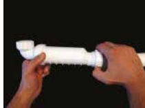
3- Hepvo® Koku Önleyici Diyafram geniş tarafı ile rakor dışını çevirerek diyafram ile birleştiriniz. Körük hortumunu çekerek montajın düzgün olup olmadığını kontrol ediniz.
