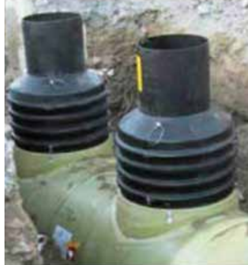
Şekil 6: EuroHUK 600 muayene bacası uygulaması
