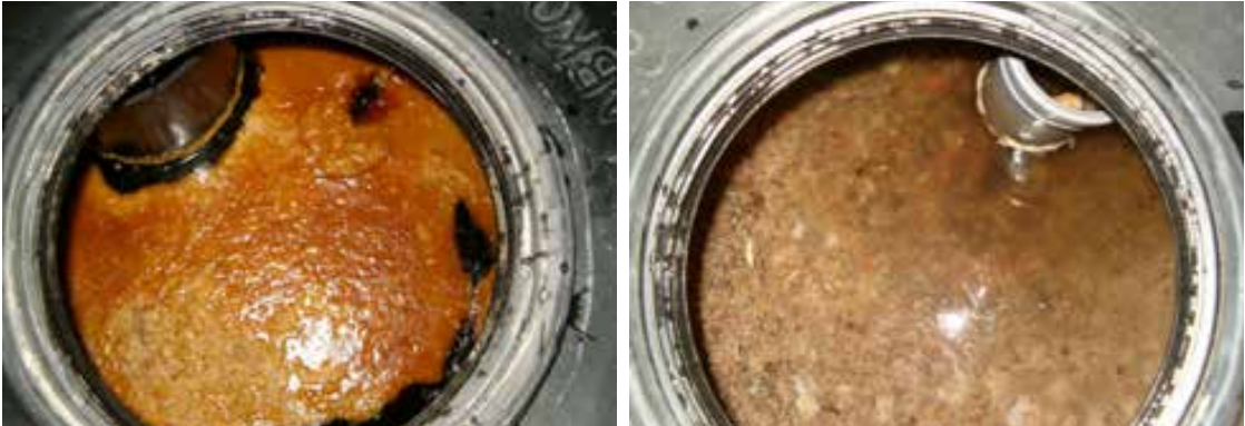
Şekil 2: Dolu yağ ayırıcıların üstten görünüşü
