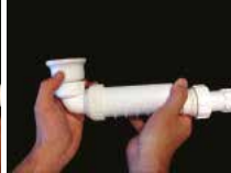
4- Lavabo süzgecinin dirseğin üst rakorlu ağzına saat yönünde çevirerek monte ediniz. Rakoru sıkarak contayı sıkıştırınız. d32'lik Hepvo® bağlantısı için kit içinde yer alan conta ayrıca kullanılmaktadır.
