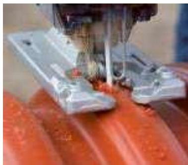
Bei Bedarf kann das Schachtrohr entsprechend der erforderlichen Einbautiefe abgelängt werden. Hierzu ist das Schachtrohr mit Hilfe einer Säge auf einer Außenwelle (äußerster Profilpunkt) zu durchtrennen.
