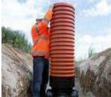
Das Schachtrohr mit eingelegter Dichtung ist auf den Schachtboden zu setzen und bis zum Anschlag einzustecken.
