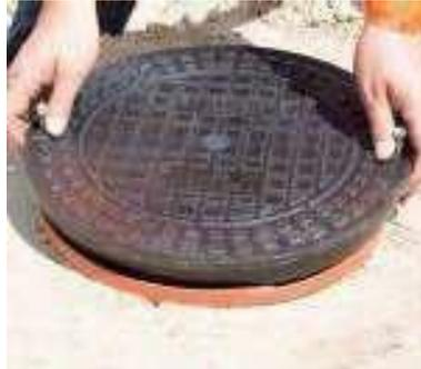
Dann sind die Außensechskantschrauben (M8) der Abdeckung mit einem Innensechskantschlüssel (13 mm) zunächst so weit zu lösen, dass die Abdeckung auf das Schachtrohrende aufgesetzt werden kann.
