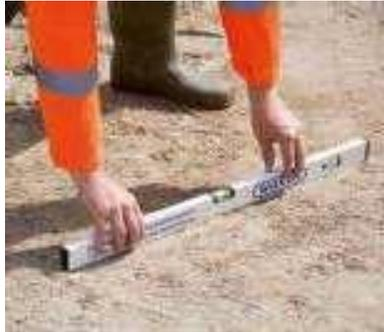
Die Aufstandsfläche des Schachtbodens ist gemäß DIN EN 1610 „Bettung Typ 1“ auszuführen. Hierbei ist das Auflager für den Schachtboden durch eine min.10cm dicke, verdichtete Sauberkeitsschicht zu bilden.
