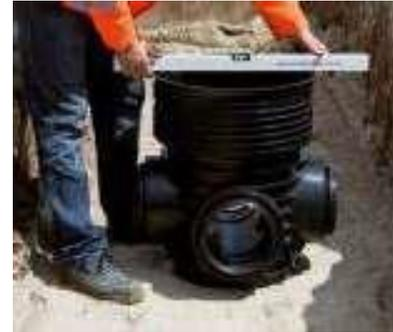
Der Schachtboden ist gemäß den Planungsvorgaben auszurichten. Hierbei ist der Schachtboden entsprechend dem erforderlichen Gefälle einzubetten. Zusätzlich ist ggf. darauf zu achten, dass die Schachtrohrmuffe senkrecht zur Rohrachse steht. Bei Bedarf kann der Schachtboden auch gemäß der Rohraufstellungsfläche bis zur Muffe in die Bettung eingelassen werden.
