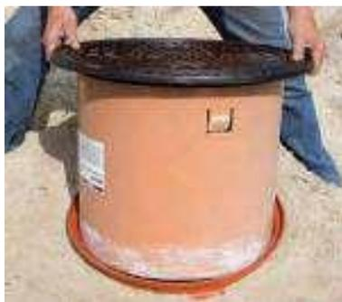
Durch das Teleskoprohr ist nun eine exakte Höhenanpassung entsprechend den Planungsvorgaben möglich. Hierbei ist auf eine Mindesteinstecktiefe von min. 100 mm im Schachtröhr zu achten. Der Schacht ist nun lagenweise (max.30cm) gemäß DIN EN 1610 weiter zu verfüllen und verdichten.
