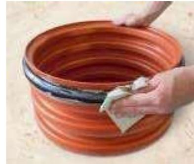
Sowohl der Dichtring als auch die Teleskopmanschette sind vor der Montage zu reinigen und auf Beschädigungen zu überprüfen. Beschädigte Bauteile dürfen nicht eingebaut werden und sind auszutauschen. Der Dichtring und die Manschette sind gleichmäßig mit Gleitmittel zu versehen.
