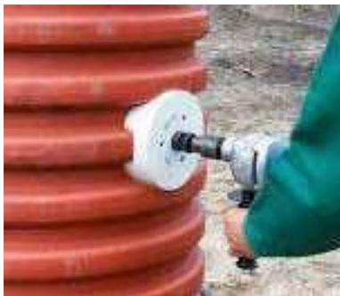
Mit einem Kronenbohrer 0127mm (Art. Nr. 4025428) bzw. 0177mm (Art. Nr. 4025429) ist zunächst ein Loch an der gewünschten Stelle in das Schachtrohr zu bohren. Die Bohrung ist abschließend zu entgraten und gegebenenfalls zu säubern.
