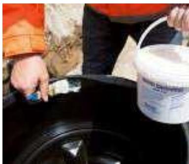
Bevor das Schachtrohr auf den Schachtboden aufgesetzt werden kann, ist der Muffenbereich des Schachtbodens gleichmäßig umlaufend mit Gleitmittel zu versehen.
