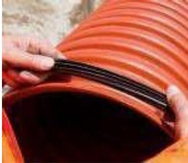
Das Schachtrohr ist für die Aufnahme der Dichtung gegebenenfalls zu säubern. Das Dichtelement ist im ersten Tal (zwischen der ersten und zweiten Welle) gemäß der Zeichnung am Dichtringlabel zu montieren. Hierbei ist auf die korrekte Richtung und den richtigen Sitz mittig im Tal zu achten.
