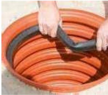
Für den Einsatz der Teleskopabdeckung ist die Dichtung im ersten Tal der Schachtröhrinnenseite zu montieren und gleichmäßig mit Gleitmittel zu bestreichen. Die Auflagefläche für die Teleskopabdeckung ist entsprechend vorzubereiten und zu verdichten. Je nach Belastung ist ggf. ein Auflager aus Ortbeton C12/15 herzustellen.
