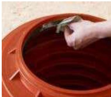
Der Dichtring und die Teleskopmanschette sind von innen zu reinigen und gleichmäßig mit Gleitmittel zu versehen.
