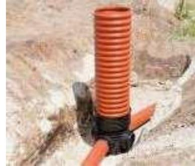
Das Spitzende des anzuschließenden Rohres ist gemäß Herstellerangaben zu säubern, anzufasen und mit Gleitmittel zu versehen. Nach dem Einstecken ist die Rohrführung entsprechend den Planungsvorgaben auszurichten. Hierzu kann das Rohr durch integrierte Kugelgelenke stufenlos in die erforderliche Richtung abgewinkelt werden. Es lassen sich sowohl Richtungsänderungen im Bereich von 15° als auch Gefälle von bis zu 13% realisieren.
