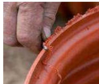
Vor dem Einlegen der Dichtelemente sind Unebenheiten an der Schachtrohrtrennkante zu entfernen und das Schachtrohr umlaufend zu entgraten.
