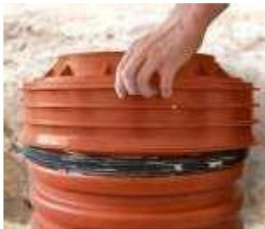
Die Teleskopmanschette ist gleichmäßig bis zum Anschlag auf das Schachtrohr zu stecken. Hierbei ist ein Verkanten zu vermeiden.
