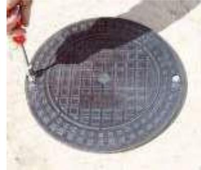
Die Außensechskantschrauben sind nach dem Aufsetzen der Abdeckung im Schachtrohr zu verschrauben. Hierbei ist die Abdeckung auf das Schachtrohr zu drücken oder zu fixieren.
