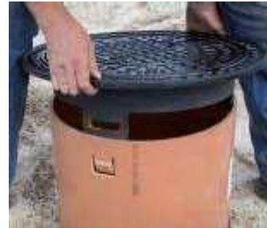
Die Gussabdeckung ist schließlich in das Teleskoprohr einzusetzen. Hierzu sind die drei Aussparungen so auszurichten, dass die Stege in die Abdeckung einrasten können.
