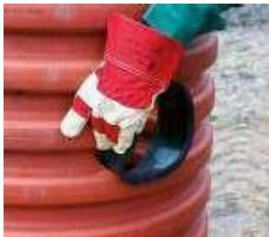
Daraufhin ist die Gummimanschette des Tegra 600 Anschluss-Stücks aus PP zunächst ohne Gleitmittel in die gebohrte Öffnung einzulegen. Erst nach erfolgreicher Montage der Gummimanschette ist diese an der Innenseite gleichmäßig mit Gleitmittel zu versehen. Es ist darauf zu achten, dass das Dichtelement an der dafür vorgesehene Position verbleibt.
