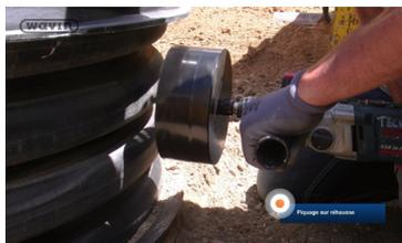
Le perçage doit être fait bien perpendiculairement à la rehausse. La fraise doit être en bon état pour réaliser correctement le perçage.
