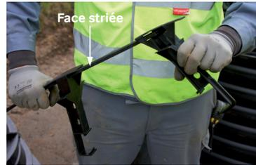
**B** - Vérifier que les crochets sont bien en vis à vis.
