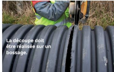
La découpe doit être réalisée sur un bossage.
