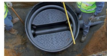
**B - Le raccordement aux tubes s'effectue par simple emboîtement après graissage de l'emboîture et du tube.**
