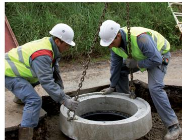
Pour mettre l'ouvrage à la cote, il est possible de rehausser ou surbaissier la couronne de 10 cm maximum. Cette opération nécessite un désassemblage de la couronne pour ajuster le niveau de remblai.
