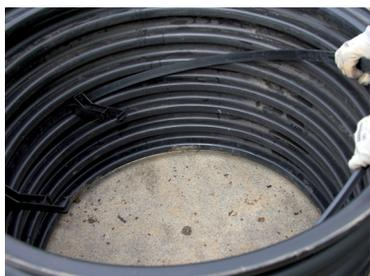
**B -** Forcer le cerclage pour mettre les deux bouts en contact.
