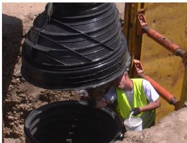
**C -** Positionner le cône sur la rehausse, vérifier l'orientation des supports d'échelle du cône avant d'emboîter le cône (pression verticale).
