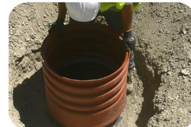
**E** - Monter le joint d'étanchéité dans l'anneure d'extrémité de la rehausse Ø 600. (Joint fourni en option - identique au précédent)
