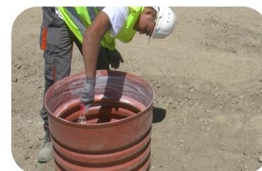
**D** - Emboîter la rehausse Ø 600 sur le cône (pression verticale).
