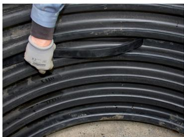
**D -** Les crochets doivent être en vis à vis de la jointure du cerclage. Ecartement : 37 cm
