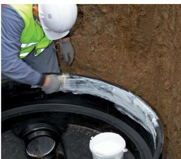
**C -** Positionner la rehausse sur le fond, vérifier l'orientation des supports d'échelle avant d'emboîter la rehausse (pression verticale).
