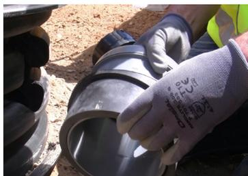
**D** - Monter le joint à sec sur la rehausse en orientant verticalement les flèches gravées.
