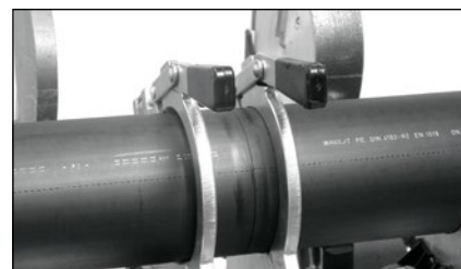
Správně připravené potrubí ke svařování
