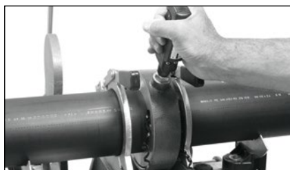
Srovnání konců potrubí integr. hoblíkem
