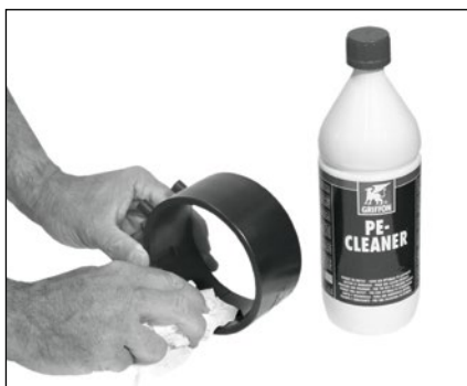
Ošetření vnitřního povrchu elektrotvarovky PE čistícím přípravkem
