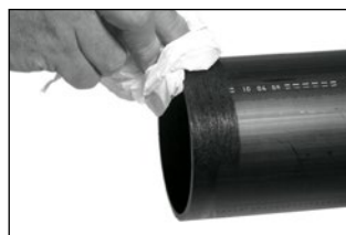
Ošetření konců potrubí PE čistícím přípravkem
