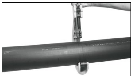
Řez potrubí ruční rotační řezačkou
