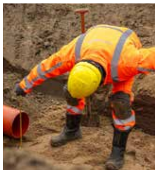
2. Ret udgravningen af og tag højde for afstand mellem bund rør og bund brønd.
