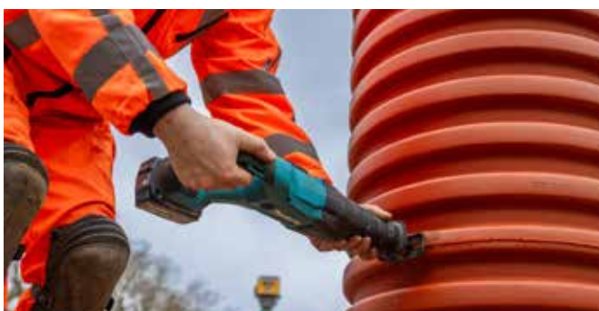
13. Afkort opføringsrøret i den korrekte højde.
