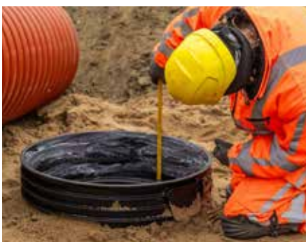
11. Mål muffedybden og marker opføringsrøret, før røret skubbes i muffen.
