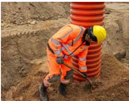
12. Tilbagefyld og komprimering i henhold til DS430. Max 30cm lag mellem komprimeringerne.
