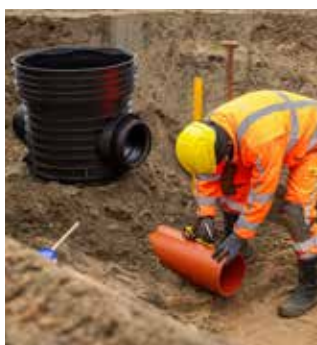
3. Mål muffedybden og afmærk røret for korrekt samling.
