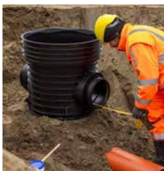
3. Mål muffedybden og afmærk røret for korrekt samling.
