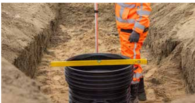
7. Tjek at installationen er korrekt nivelleret.
