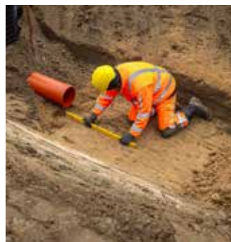
2. Ret udgravningen af og tag højde for afstand mellem bund rør og bund brønd.
