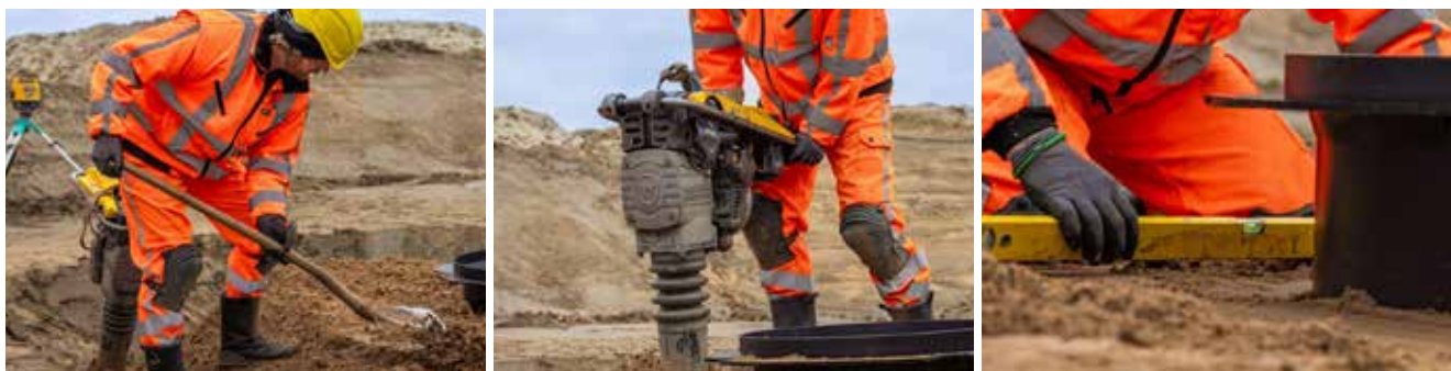
16. Afretning og komprimering omkring dækslet til færdig højde.
