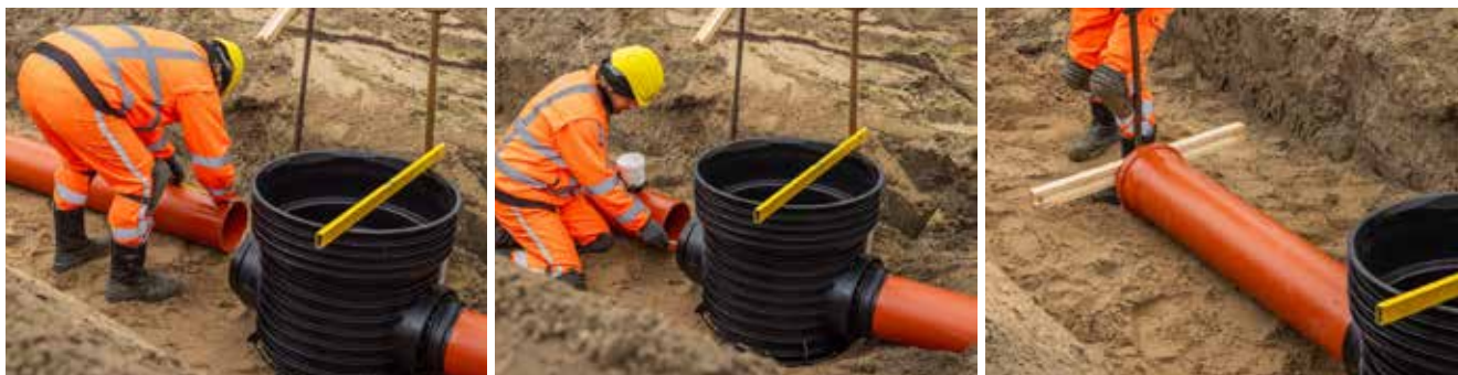
6. Inden installation af afgangsrøret kontrollerer højden på afretningslaget til rør i forhold til brønd.
