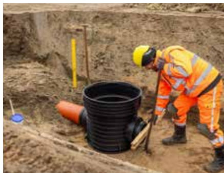
4. Rengør spidsenden og smør muffen med glidemiddel. Placer brønden foran røret og skub sammen, indtil markeringen er ud for muffen. Brug gerne et stykke træ mellem skubbestang og brønd.
