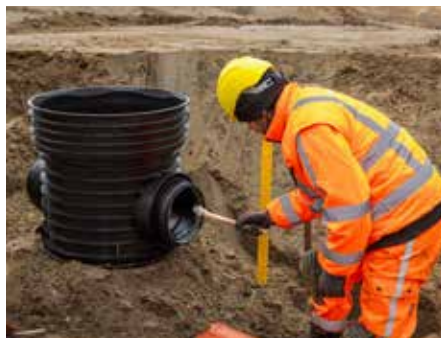
4. Rengør spidsenden og smør muffen med glidemiddel. Placer brønden foran røret og skub sammen, indtil markeringen er ud for muffen. Brug gerne et stykke træ mellem skubbestang og brønd.
