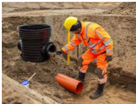
4. Rengør spidsenden og smør muffen med glidemiddel. Placer brønden foran røret og skub sammen, indtil markeringen er ud for muffen. Brug gerne et stykke træ mellem skubbestang og brønd.
