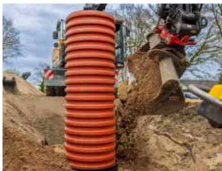
12. Tilbagefyld og komprimering i henhold til DS430. Max 30cm lag mellem komprimeringerne.
