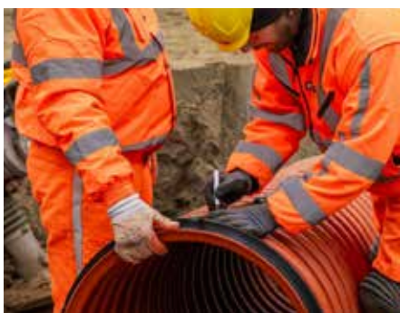
11. Mål muffedybden og marker opføringsrøret, før røret skubbes i muffen.
