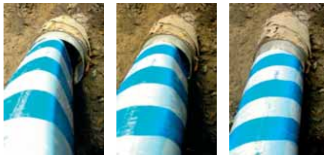
Рис. 37. Compact SlimLiner расширена с использованием "холодного" процесса
