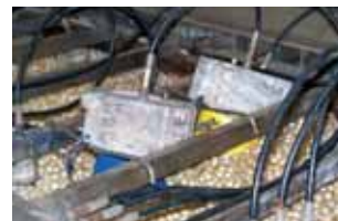
Рис. 46. Гидравлическая опрессовка (испытание на этапе "У").
