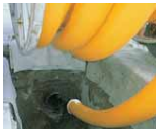
Рис. 59. Compact Pipe в Мадриде, Испания
