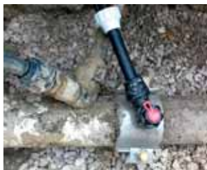
Рис. 39. Подключение отвода с использованием компактного патрубка
