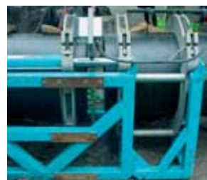
Рис. 19. Сварка встык полиэтиленовых труб
