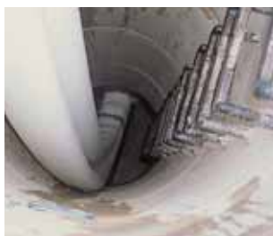
Рис. 29. Для восстановления канализации могут использоваться существующие колодцы
