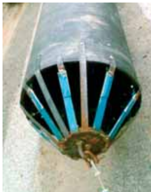
Рис. 20. Металлический наконечник для протягивания (слева) и полиэтиленовая заглушка, приваренная встык к торцу трубы.
