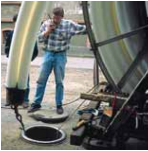
Рис. 22. Для восстановления канализационных труб могут использоваться существующие колодцы
