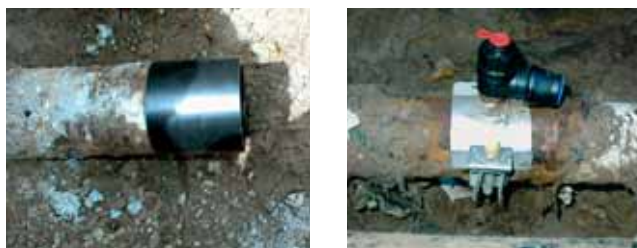
Рис. 35. Концевой фитинг и патрубок для подключения
