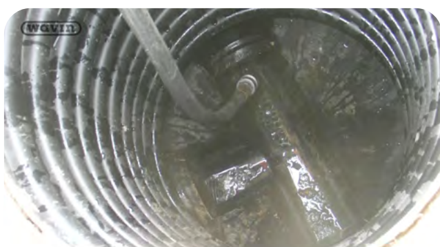
- MISE EN PLACE DE LA TÊTE DE L'HYDROCUREUSE DANS LE COLLECTEUR SOUHAITÉ
