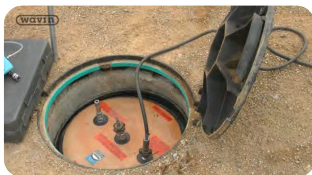
→ MISE EN PLACE DU BALLON SUR LA PARTIE SUPÉRIEURE
