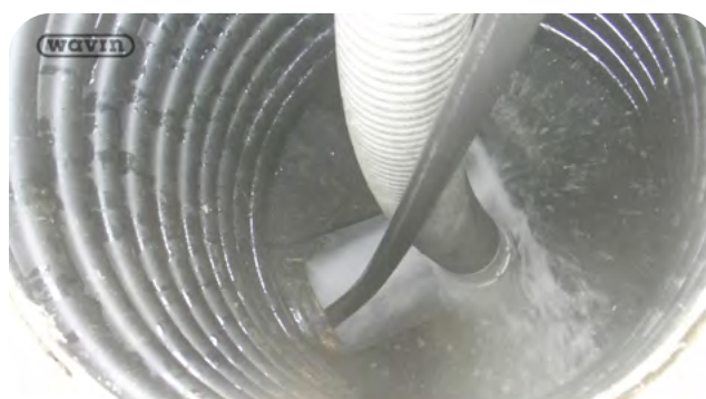
- HYDROCURATION DU COLLECTEUR
