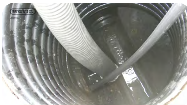
- MISE EN PLACE DU TUYAU D'ASPIRATION
