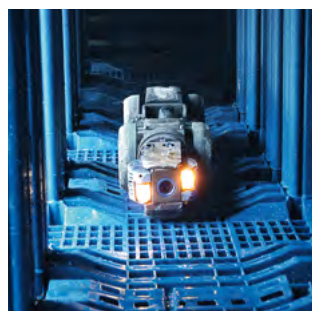
Inspection par caméra
