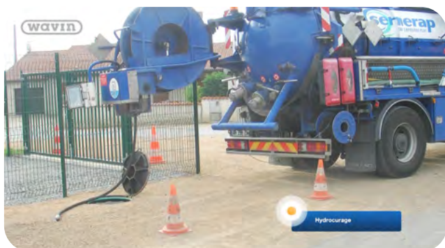
- MISE EN PLACE DE L'HYDROCUREUSE
