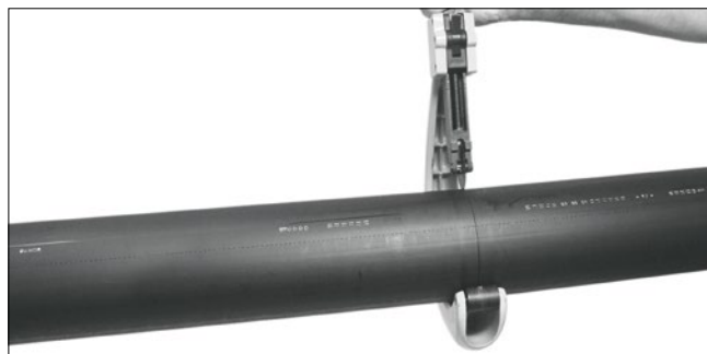
Řez potrubí ruční rotační řezačkou
