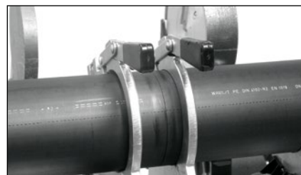
Správně připravené potrubí ke svařování
