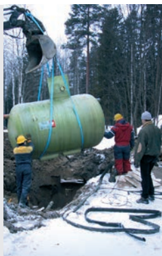
Oczyszczalnie BioKem® 10 EN i BioKem® 15 EN są wykonane z GRP – laminatu poliestrowego wzmocnianego włókłem szklanym.
