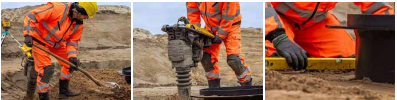
16. Avretting og komprimering rundt valgt topløsning.
