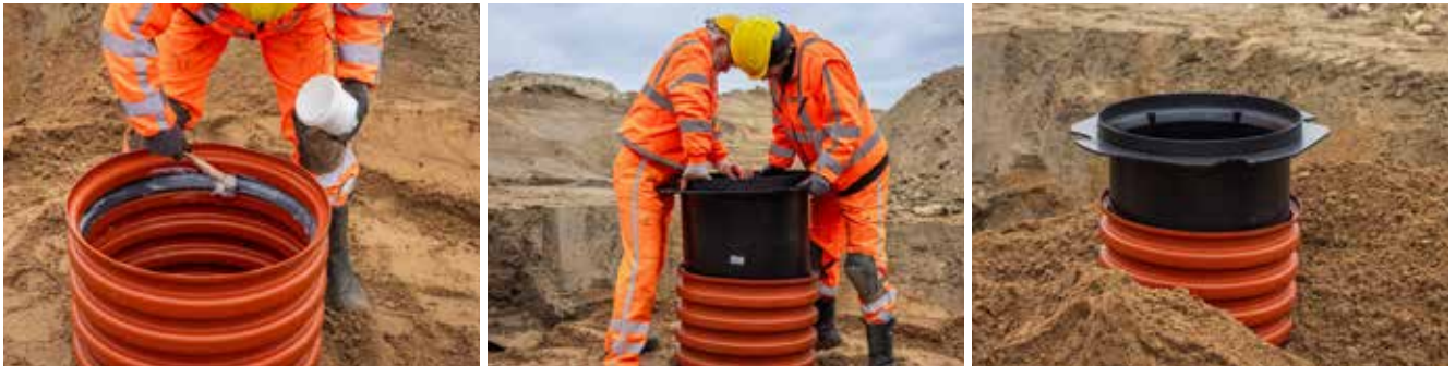
15. Påfør glidemiddel og sett inn teleskoprør eller kumrammen med langt skjørt.
