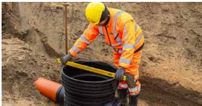
5. Sjekk at kummen fortsatt er i vater.
