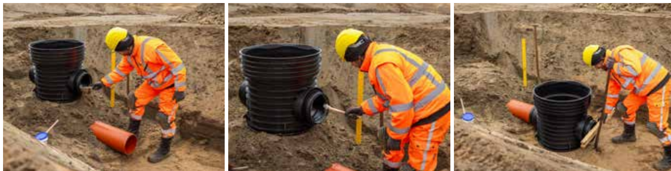
4. Rengjør rørsnitt og smør muffen med glidemiddel. Plasser kummen foran røret og skyv den sammen til markeringen er på linje med muffen. Det anbefales å bruke et trestykke mellom spett og kum.
