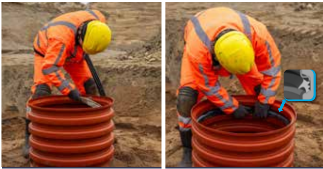
14. For teleskopløsning eller kumramme med langt skjørt, monteres teleskoppakning inni den øvre rillen i røret.
