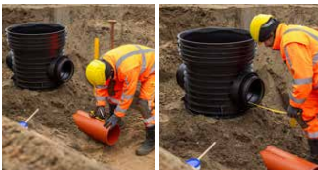
3. Mål muffedybde og merk røret for riktig montering.
