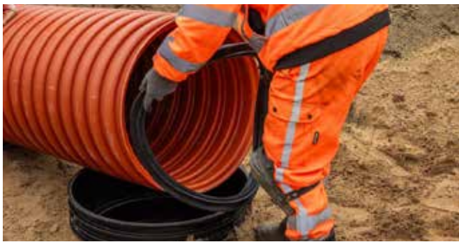
9. Rengjør rørenden og fest gummipakningen.
