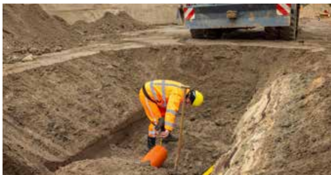
1. Kumbunnen monteres på et avrettet fundament.
