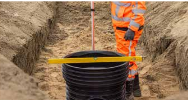
7. Kontroller at installasjon er i vater.
