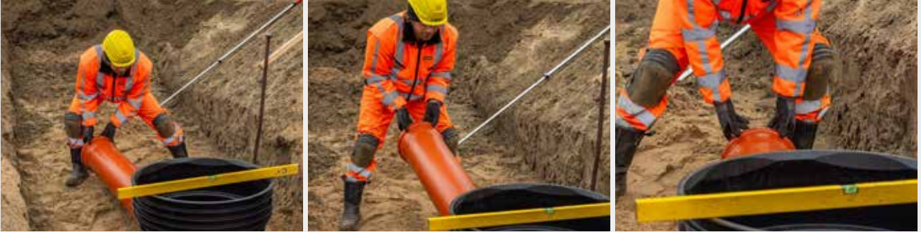
Merk: Kumbunnen er utstyrt med fleksible muffers som tillater 10 graders avvinkling både vertikalt og horisontalt.
