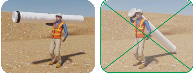
Figura 5.7. No arrastrar las tuberías
