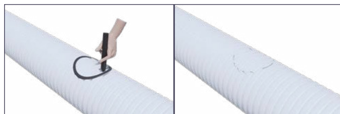
Figura 6.16 Marcar el contorno
