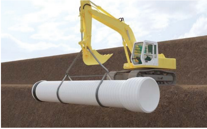
Figura 6.2. Manipuleo en zanja
