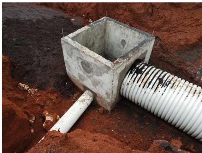
Figura 6.22. Conexión a Cámaras Rígidas
