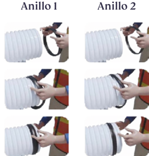
Figura 6.4. Colocación de Anillo Elastomérico
