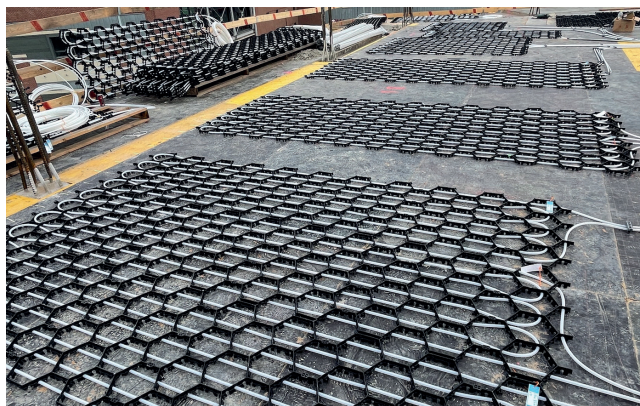
Födémzsaluzatra fektetett Wavin CW-90 regiszter panelek
