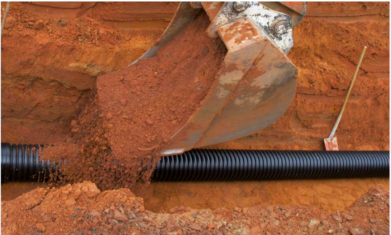
Einfache Lagesicherung durch Sandkegelaufschüttung
