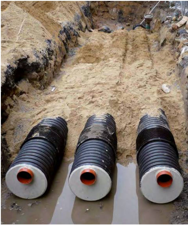
Sonderanwendung als Regenwasserstauraumkanal
