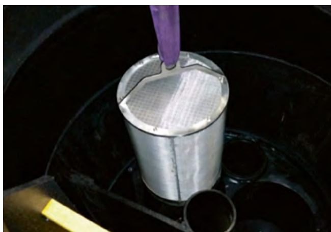
Herausheben der Kartusche
