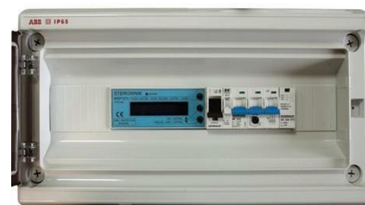
Rysunek 2. Szafka zasilająco-sterownicza przepompowni z zasilaniem 1-fazowym
