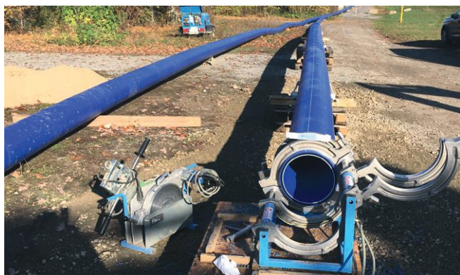
Heizwendelstumpfschweißung
