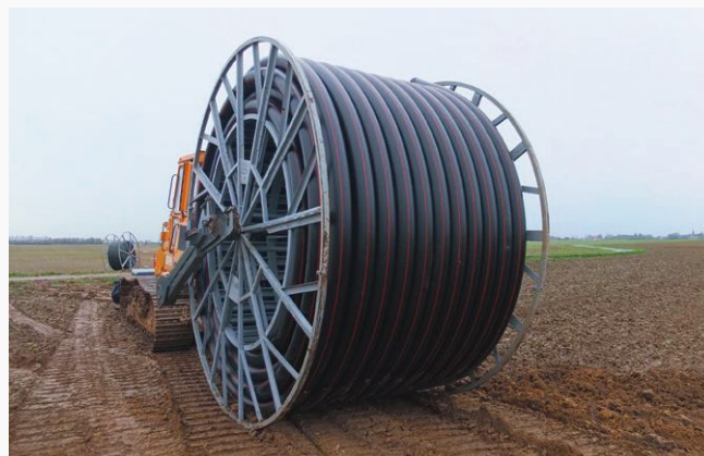
Großtrommel auf der Baustelle
