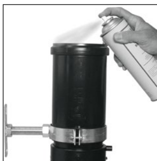
Mazání styčných ploch mezi trubkou a kompenzačním hrdlem
