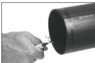
Odstranění otřepů a nerovností řezu
