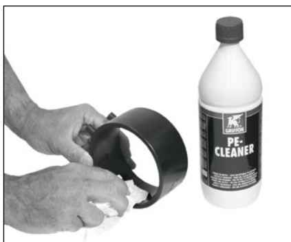
Ošetření vnitřního povrchu elektrotvarovky PE čisticím přípravkem
