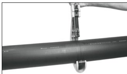
Řez potrubí ruční rotační řezačkou
