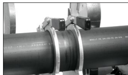
Správně připravené potrubí ke svařování
