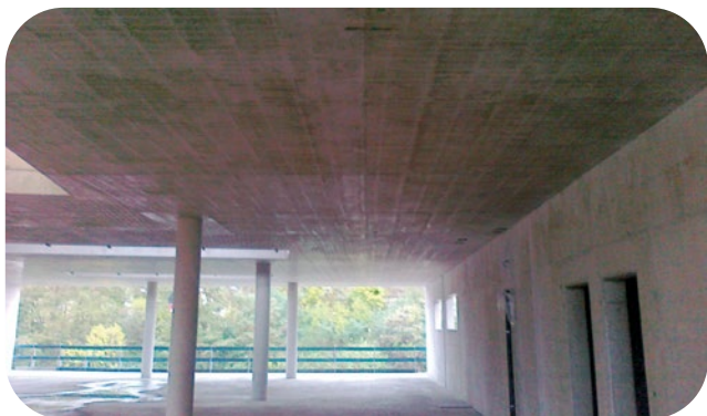
Hotová stropní deska
