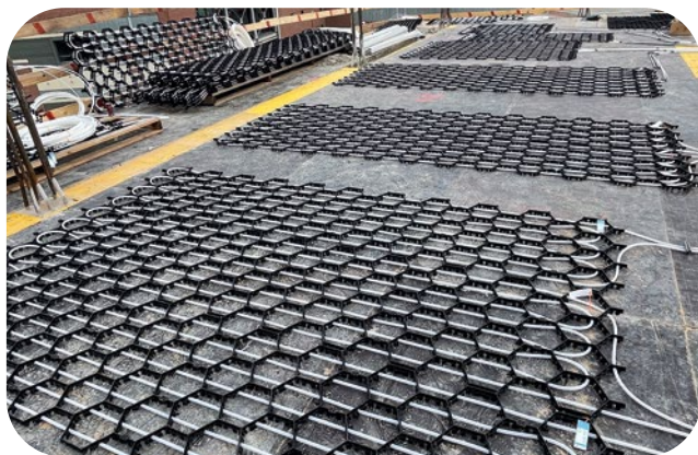
Registrované panely Wavin Comfia CW-90 položené na bednění desek.
