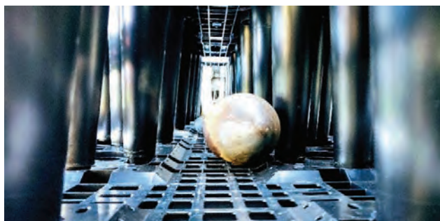
Rys. 9.2.3.3. Czyszczenie systemu Wavin AquaCell 400.
