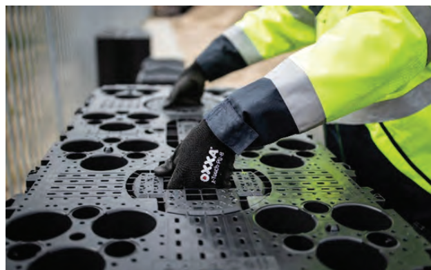
Rys. 9.2.4.4. Montaż zbiornika AquaCell 400 - ergonomiczne uchwyty.
