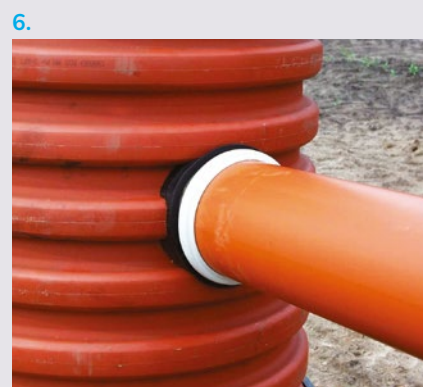
Takto instalovaná spojka IN-SITU je připravena na vsunutí roury.
