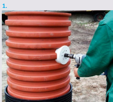
Speciálním vrtákem se vyvrtá otvor ve vlnité rouře.
