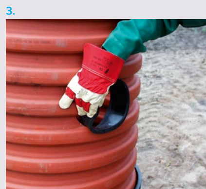
Vloží se těsnění spojky IN-SITU.
