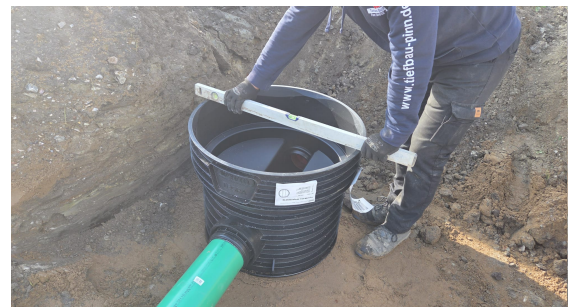
Ausrichtung des Schachts direkt in der Baugrube.
