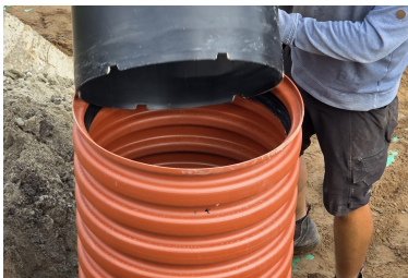
Montage des Schachtaufbaus auf dem Schachtrohr.
