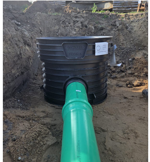
Anschluss der Zulaufleitung an den Tegra 600 LC.
