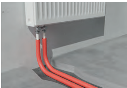
47. ábra: Példák radiátorok felszerelésére „Eurokónuszos” menetes csatlakozóval
