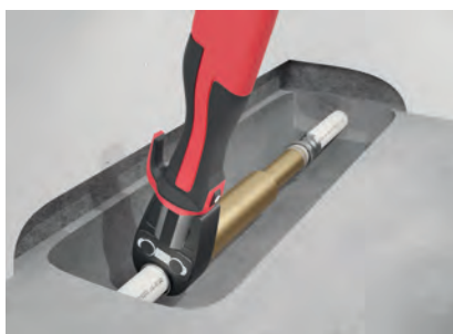
29. ábra: A javító adapter felszerelésének lépései
