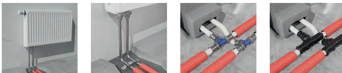
49. ábra: Radiátor csőcsatlakozás hajlított csatlakozókkal
