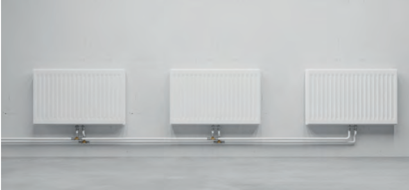
46. ábra: Kétcsöves radiátoros fűtés
