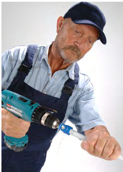
22. ábra: A cső kalibrálása
