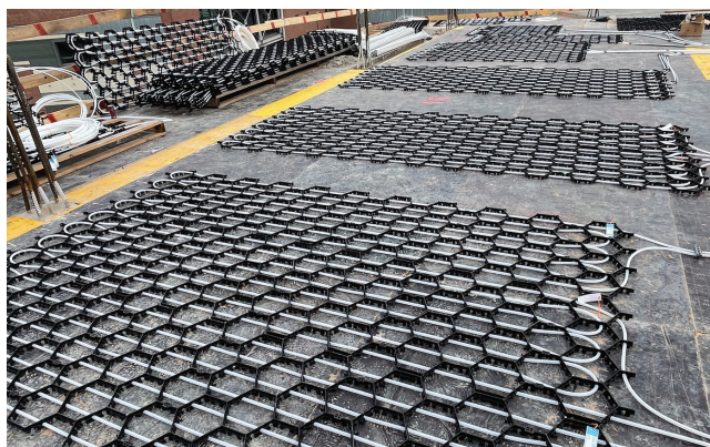
Födémzsaluzatra fektetett Wavin CW-90 regiszter panelek
