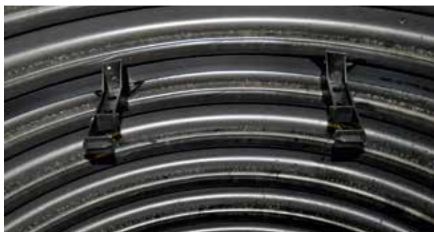
Rys. 5: Premontaż obejmy drabinki w rurze trzonowej.
